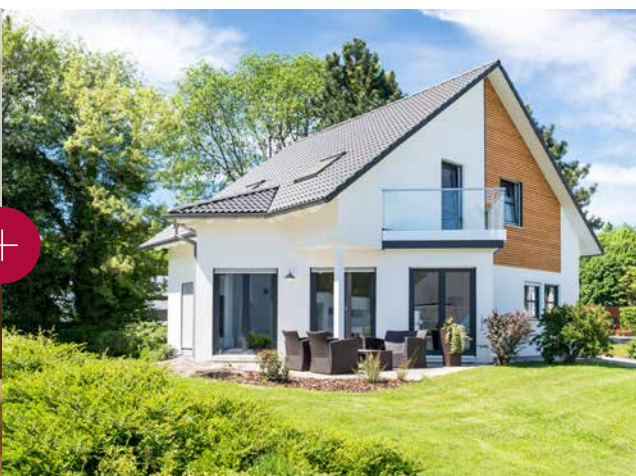
Außen am Aufstellort der Wärmepumpe
